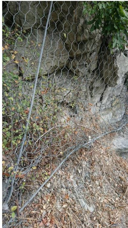
*Foto 24 - Particolare rottura collegamento rete/fune*
