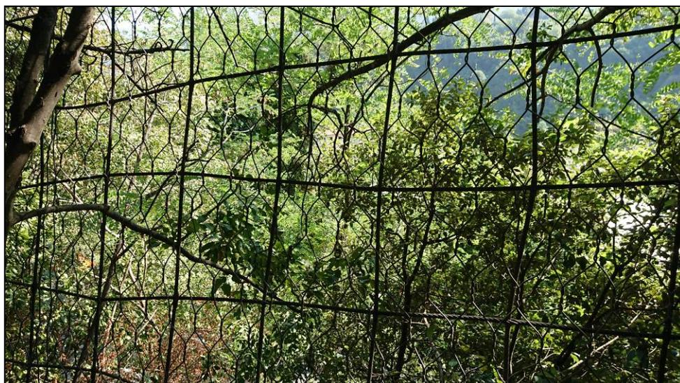
Foto 15 - Struttura di intercettazione a funi e rete presente nell'area in esame
