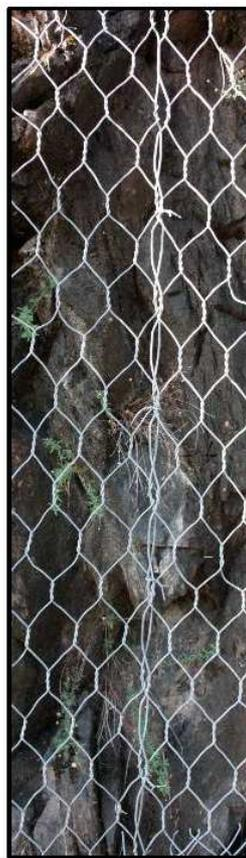
La giunzione tra un pannello di rete ed il successivo avviene senza sovrapposizione tramite legature in filo d'acciaio.
